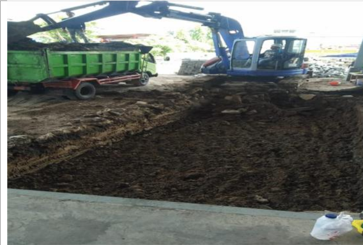
TAHAP-1 : TAHAP PERSIAPAN REPAIR EKSISTING DAN PENGURUKAN SIRTU BARU SERTA DIPADATKAN
