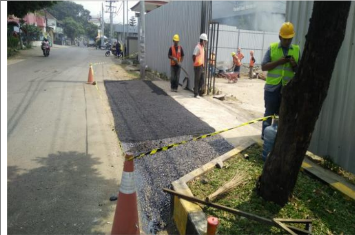
TAHAP-5 : PENGAPLIKASIAN PEMADATAN SECARA MENYELURUH DENGAN MESIN WALLS / MESIN BABY ROLLER
