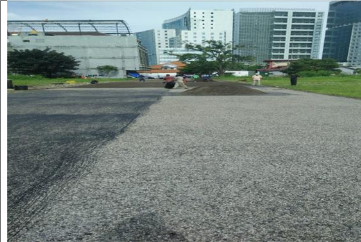
TAHAP-4 : PEMASANGAN SCREED COAT / PRIMER KEMUDIAN DI APLIKASIKAN ASPHALT HOMIX 2CM S.D 3CM
