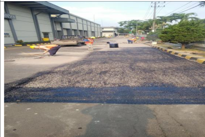
TAHAP-4 : PEMASANGAN SCREED COAT / PRIMER KEMUDIAN DI APLIKASIKAN ASPHALT HOMIX 2CM S.D 3CM
