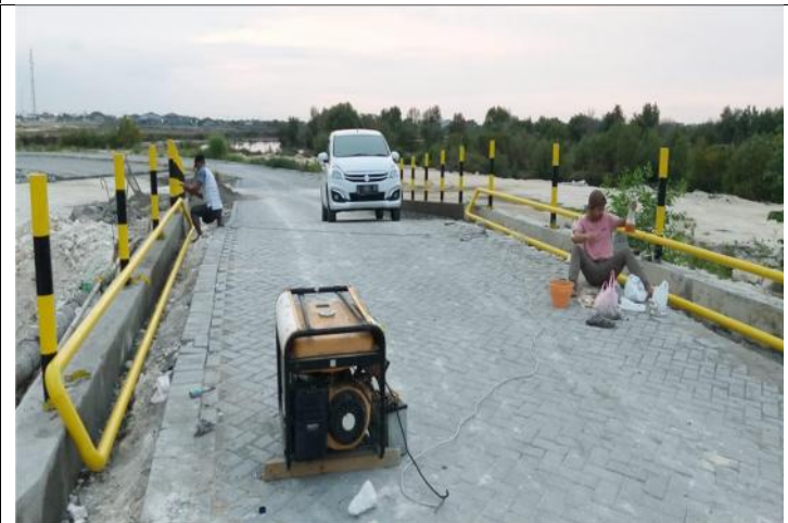
BIDANG LAINNYA : PEMASANGAN PAVING DENGAN MUTU BETEON MENGIKUTI SESUAI KEBUTUHAN USER
