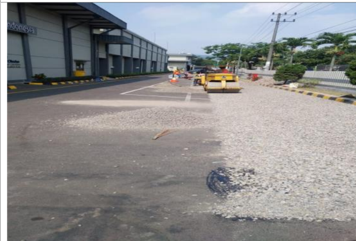
TAHAP-3 : PEMASANGAN BATU SPLIT LALU DIPADATKAN KEMUDIAN PEMASANGAN SCREED COAT / TEACK COAT
