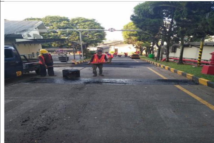
TAHAP-4 : PEMASANGAN SCREED COAT / PRIMER KEMUDIAN DI APLIKASIKAN ASPHALT HOMIX 2CM S.D 3CM
