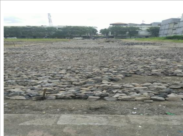
TAHAP-2 : PEMASANGAN BATU MAKADAM LALU DIPADATKAN SESUAI LEVELLING / ELEFASI YANG DITENTUKAN SHOP DRAWING
