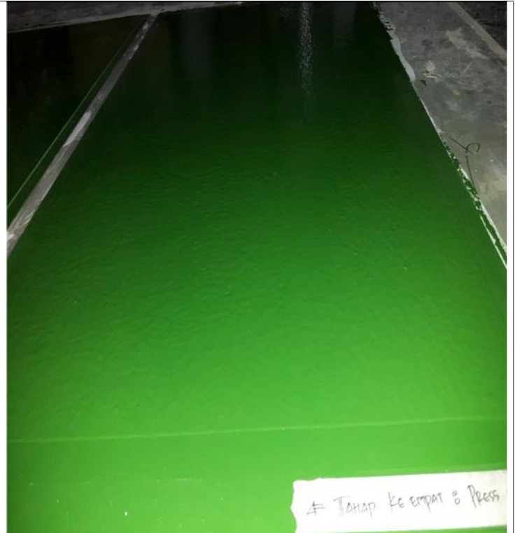
EPOXY FLOORING SIKAFLOOR 263 HIJAU (KODE RAL.6010)
