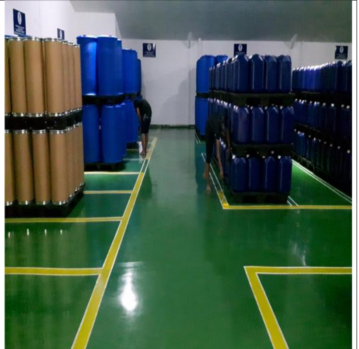
EPOXY FLOORING SIKAFLOOR 263 HIJAU (KODE RAL.6010) DAN MARKING LINE WARNA KUNING (KODE RAL.1021)
