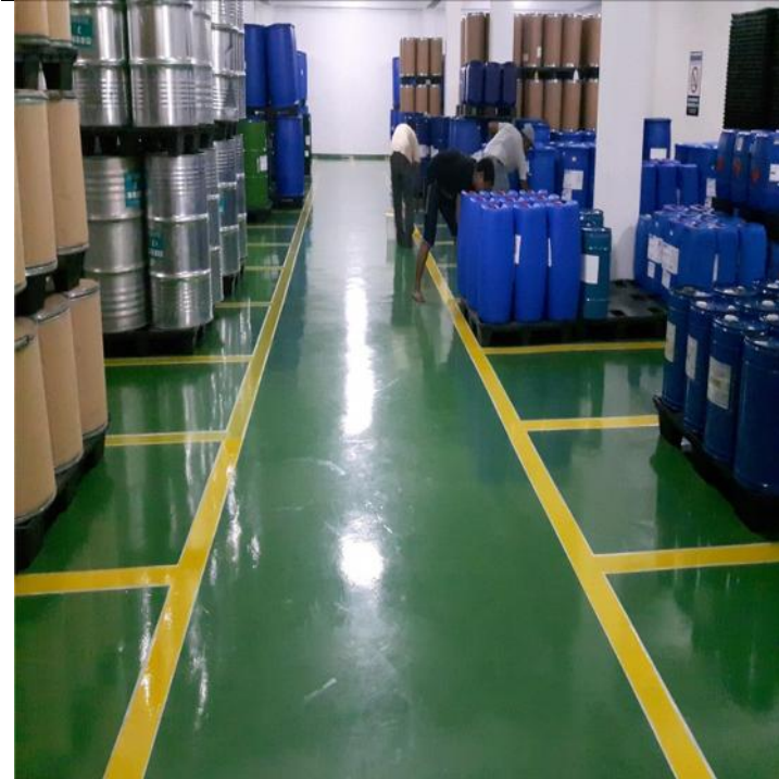
EPOXY FLOORING SIKAFLOOR 263 HIJAU (KODE RAL.6010) DAN MARKING LINE WARNA KUNING (KODE RAL.1021)
