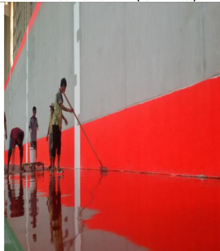
EPOXY FLOORING BASF MERAH (KODE RAL.3000)
