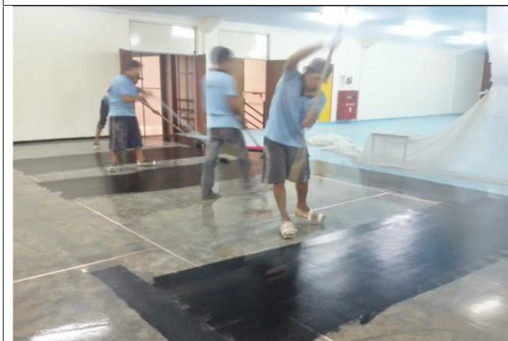
TAHAP-8 : PEMASANGAN EPOXY BERBASIS SERAT CARBON UNTUK MERATAKAN MEDIA LANTAI TERKONEKSI SEMUA
