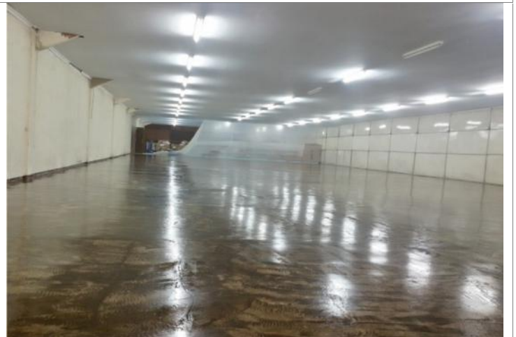
TAHAP-3 : PENGAPLIKASIAN EPOXY PRIMER (SYSTEM PRES TROWEL & ROLL LAPISAN KEDUA)
