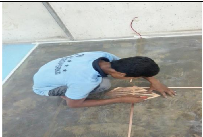
TAHAP-6 : PEMASANGAN PLAT TEMBAGA BERBENTUK JARING UNTUK MENDISTRIBUSIKAN KE KABEL TEMBAGA
