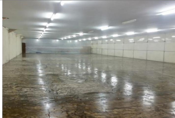
TAHAP-2 : PENGAPLIKASIAN EPOXY PRIMER (SYSTEM PRES TROWEL LAPISAN PERTAMA / SCREED COAT)
