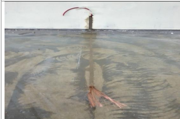
TAHAP-5 : HASIL JADI SETELAH KERING EPOXY MORTAR YANG MENUTUP TANAMAN KABEL TEMBAGA
