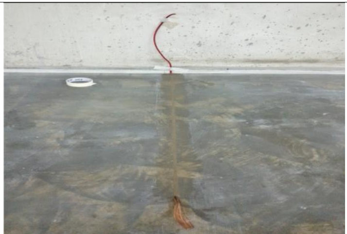
TAHAP-5 : HASIL JADI SETELAH KERING EPOXY MORTAR YANG MENUTUP TANAMAN KABEL TEMBAGA
