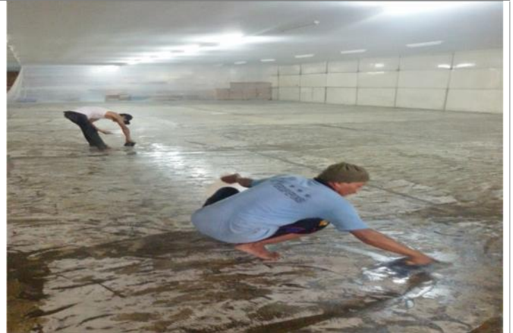
TAHAP-2 : PENGAPLIKASIAN EPOXY PRIMER (SYSTEM PRES TROWEL LAPISAN PERTAMA / SCREED COAT)
