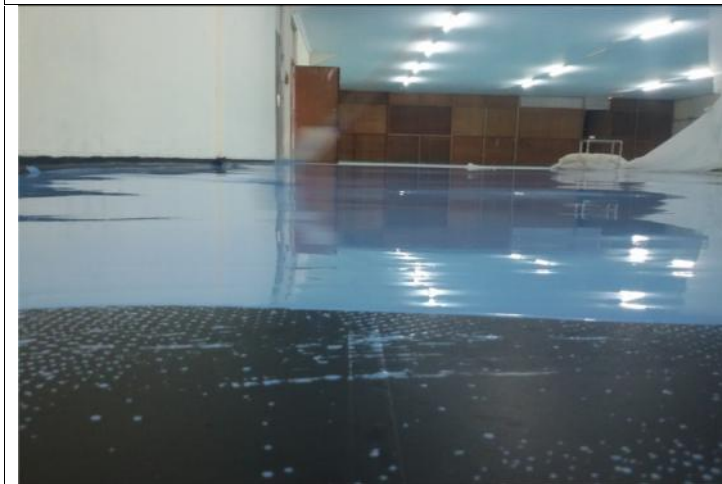
TAHAP-11 : PEMASANGAN EPOXY BERBASIS STEEL SHOT (SYSTEM SELF LEVELLING / TOP COAT)
