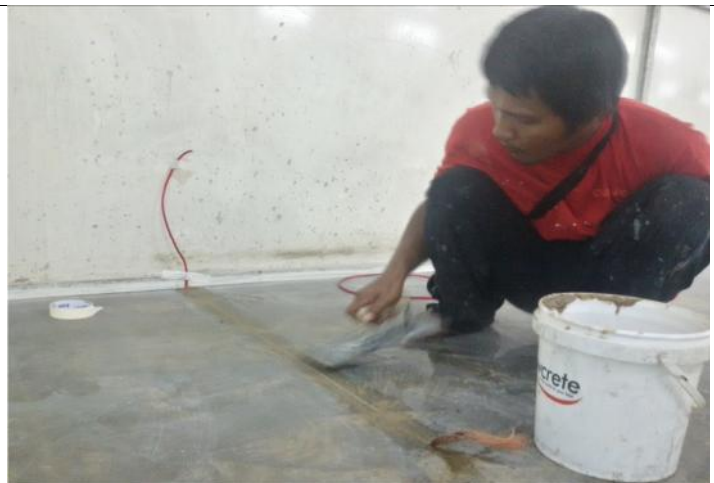
TAHAP-4 : CUTTING BETUK "U" UNTUK TANAM KABEL TEMBAGA KEMUDIAN DITUTUP DENGAN EPOXY MORTAR
