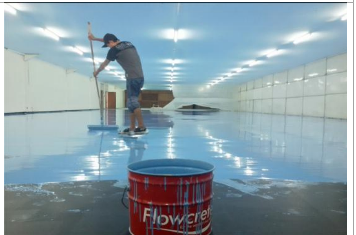
TAHAP-11 : PEMASANGAN EPOXY BERBASIS STEEL SHOT (SYSTEM SELF LEVELLING / TOP COAT)
