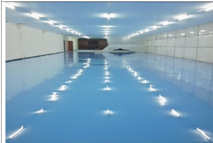
TAHAP-12 : HASIL JADI DAN KERING PEMASANGAN EPOXY BERBASIS STEEL SHOT (SYSTEM SELF LEVELLING / TOP COAT)
