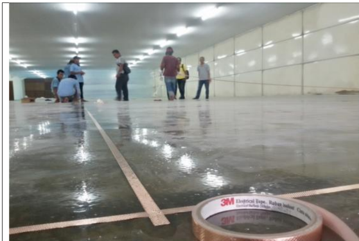
TAHAP-7 : PEMASANGAN PLAT TEMBAGA BERBENTUK KOTAK - KOTAK UNTUK MENDISTRIBUSIKAN KE KABEL TEMBAGA
