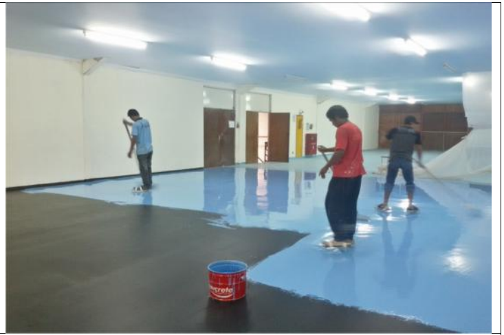
TAHAP-10 : PEMASANGAN EPOXY BERBASIS STEEL SHOT UNTUK MERATAKAN MEDIA LANTAI TERKONEKSI SEMUA
