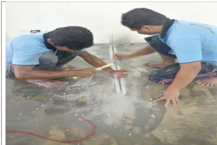
TAHAP-4 : CUTTING BETUK "U" UNTUK TANAM KABEL TEMBAGA KEMUDIAN DITUTUP DENGAN EPOXY MORTAR
