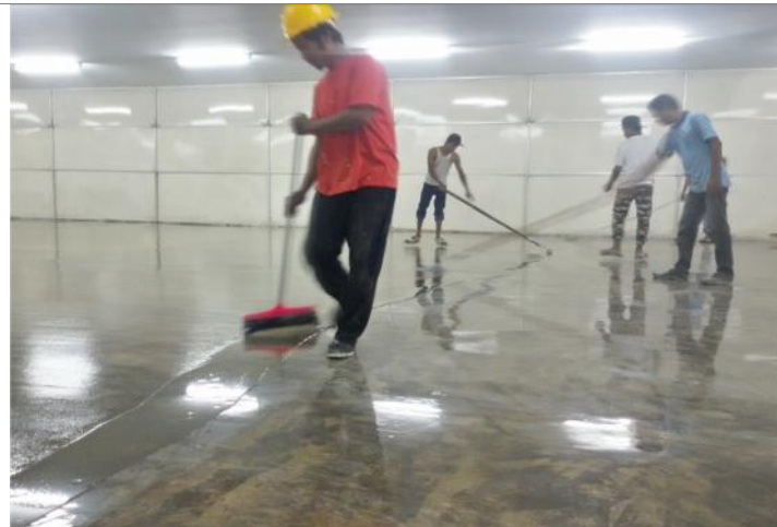
TAHAP-3 : PENGAPLIKASIAN EPOXY PRIMER (SYSTEM PRES TROWEL & ROLL LAPISAN KEDUA)
