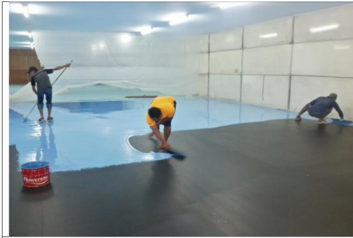
TAHAP-10 : PEMASANGAN EPOXY BERBASIS STEEL SHOT UNTUK MERATAKAN MEDIA LANTAI TERKONEKSI SEMUA
