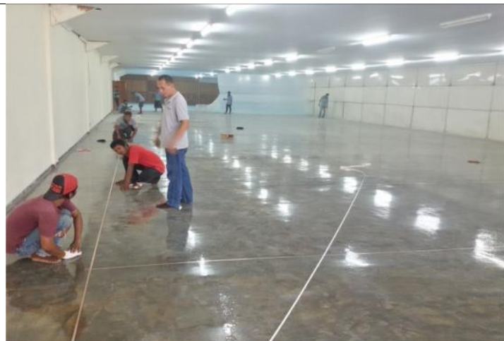
TAHAP-7 : PEMASANGAN PLAT TEMBAGA BERBENTUK KOTAK - KOTAK UNTUK MENDISTRIBUSIKAN KE KABEL TEMBAGA
