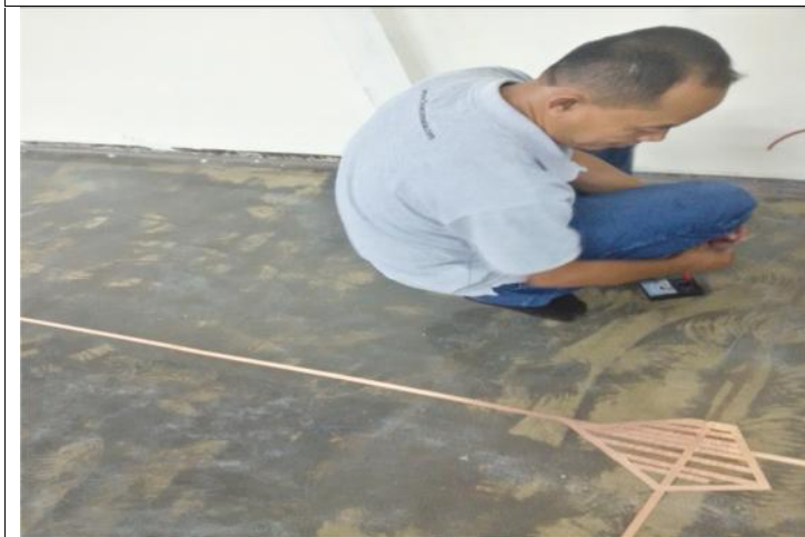
TAHAP-6 : PEMASANGAN PLAT TEMBAGA BERBENTUK JARING UNTUK MENDISTRIBUSIKAN KE KABEL TEMBAGA
