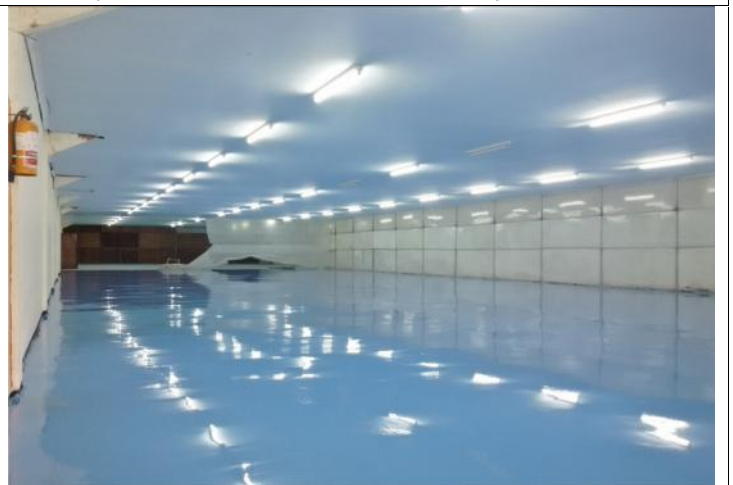
TAHAP-12 : HASIL JADI DAN KERING PEMASANGAN EPOXY BERBASIS STEEL SHOT (SYSTEM SELF LEVELLING / TOP COAT)
