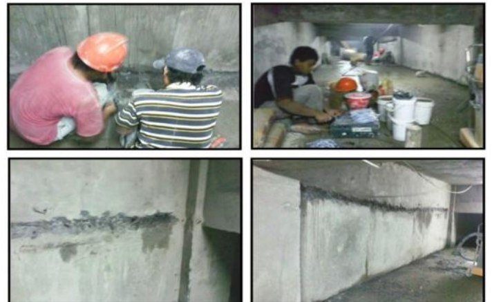
GWT-2 APLIKASI SURFACE PEKERJAAN GRINDING
