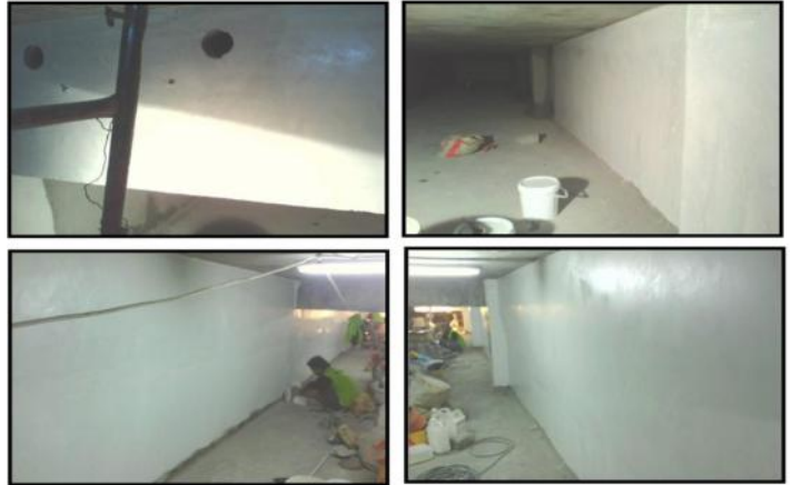
GWT-1 APLIKASI COATING PEKERJAAN COATING EPOXY
