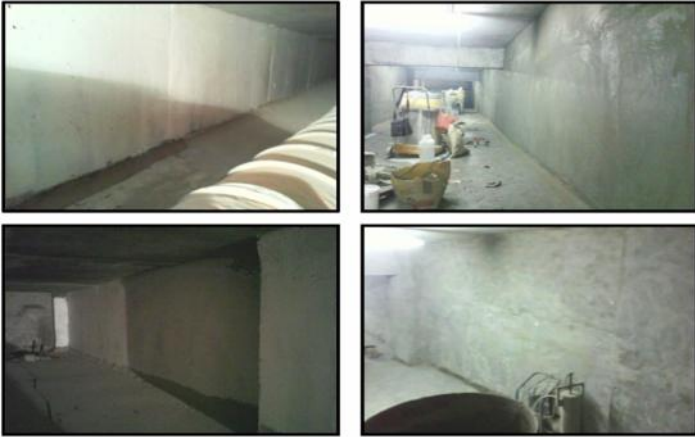
GWT-1 APLIKASI COVING PEKERJAAN COVING R2" EPOXY
