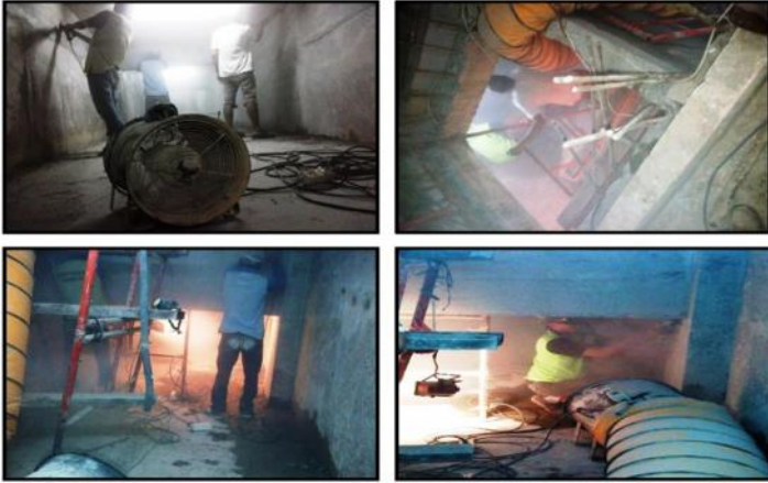
GWT-1 APLIKASI SURFACE PEKERJAAN GRINDING
