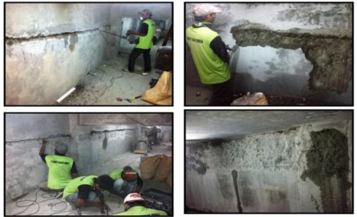
GWT-1 APLIKASI INJEKSI PEKERJAAN REPAIR BETON DAN INJEKSI
