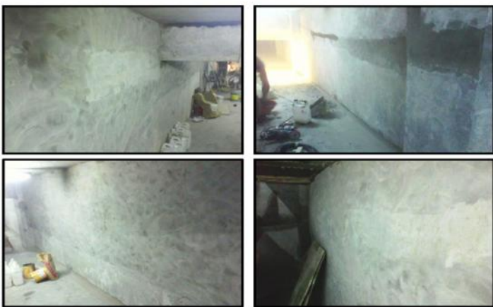
GWT-1 APLIKASI INJEKSI PEKERJAAN REPAIR BETON DAN INJEKSI
