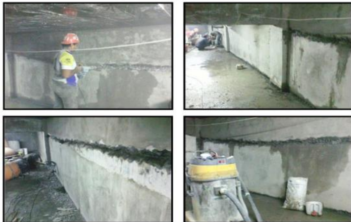
GWT-2 APLIKASI INJEKSI PEKERJAAN REPAIR BETON DAN INJEKSI
