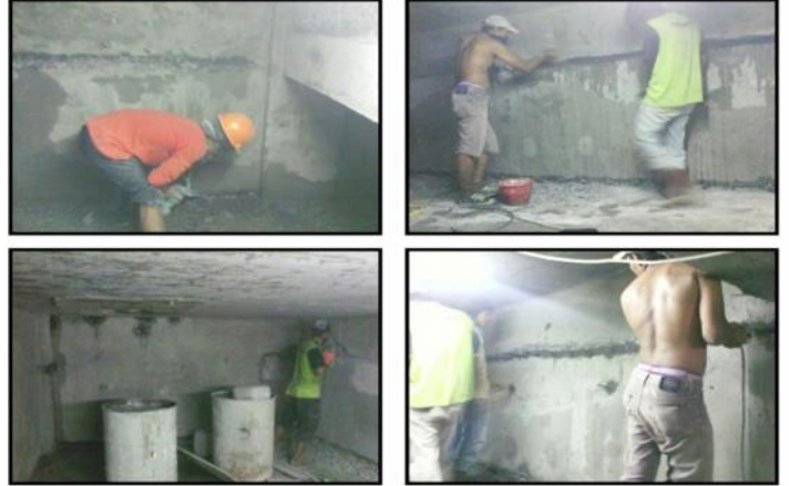
GWT-2 APLIKASI INJEKSI PEKERJAAN REPAIR BETON DAN INJEKSI
