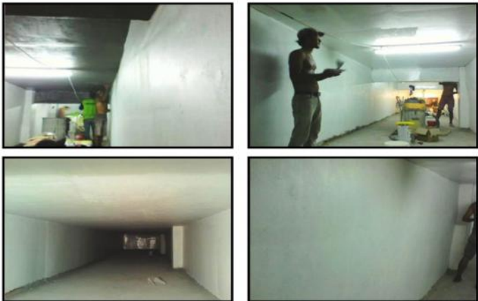
GWT-1 APLIKASI COATING PEKERJAAN COATING EPOXY
